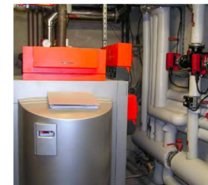
Chaudière gaz à condensation (plus économe) installée dans le complexe Pépi en 2017.
